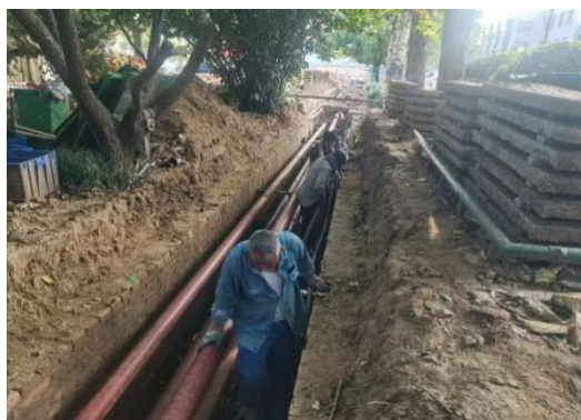
图7-4：暖气管施工
