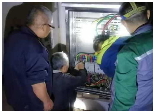
图7-10：校园水电维修
