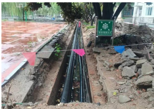
图7-3：自来水管施工
